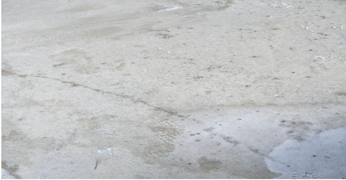
厂区地面硬覆盖
