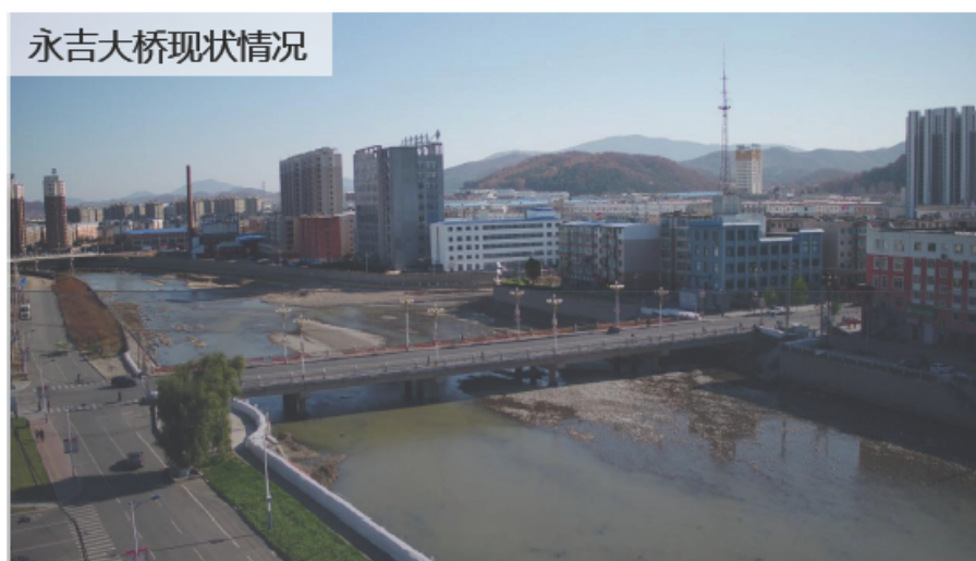
图 5-4 永吉大桥与滨北路交叉方式现状图
