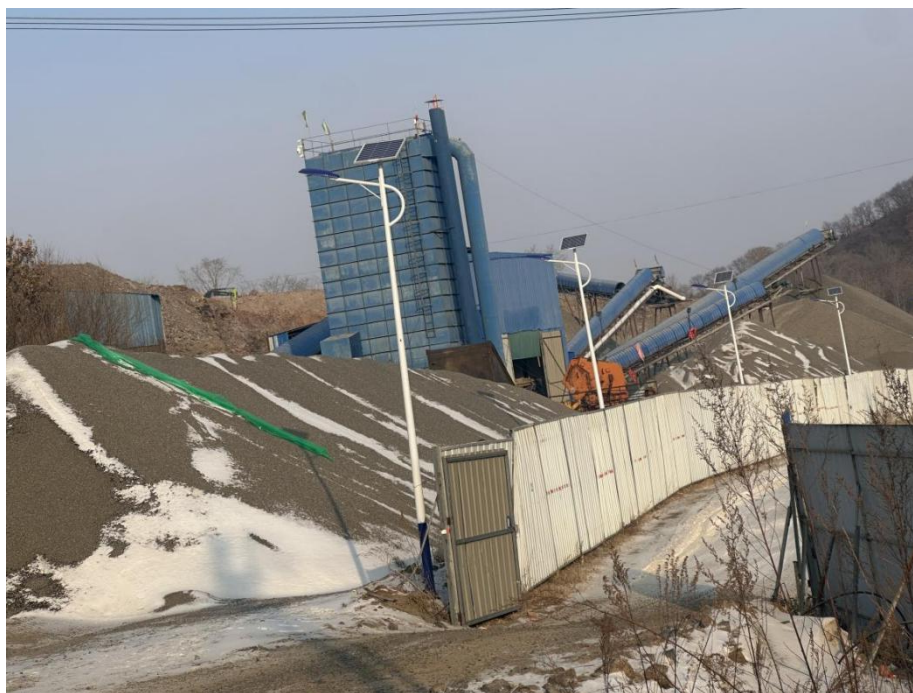
照片 1-2 露天采场西侧工业广场
