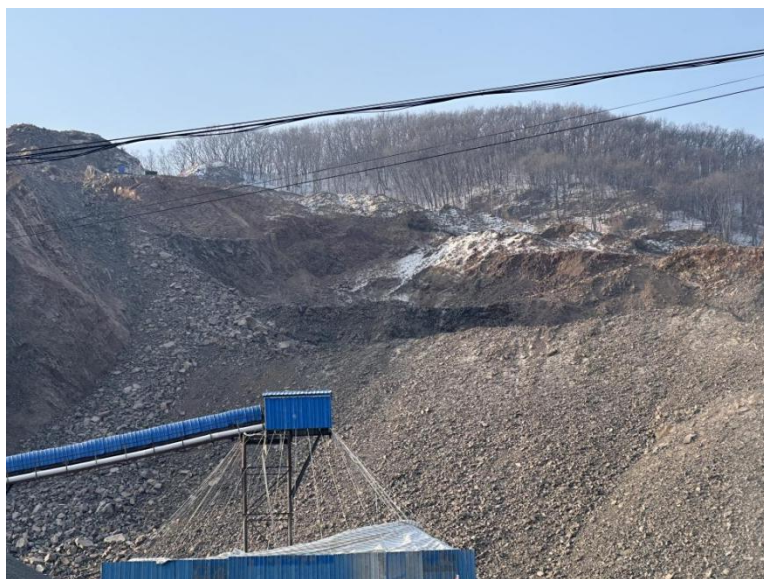
照片 3-2 露天采场现状照片
