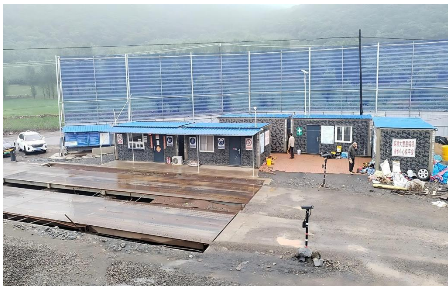
照片 3-5 露天采场底部仓库及维修车间
