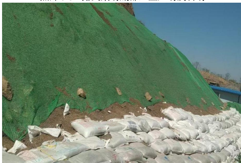
照片 3-4 露天采场底部已有表土堆场
