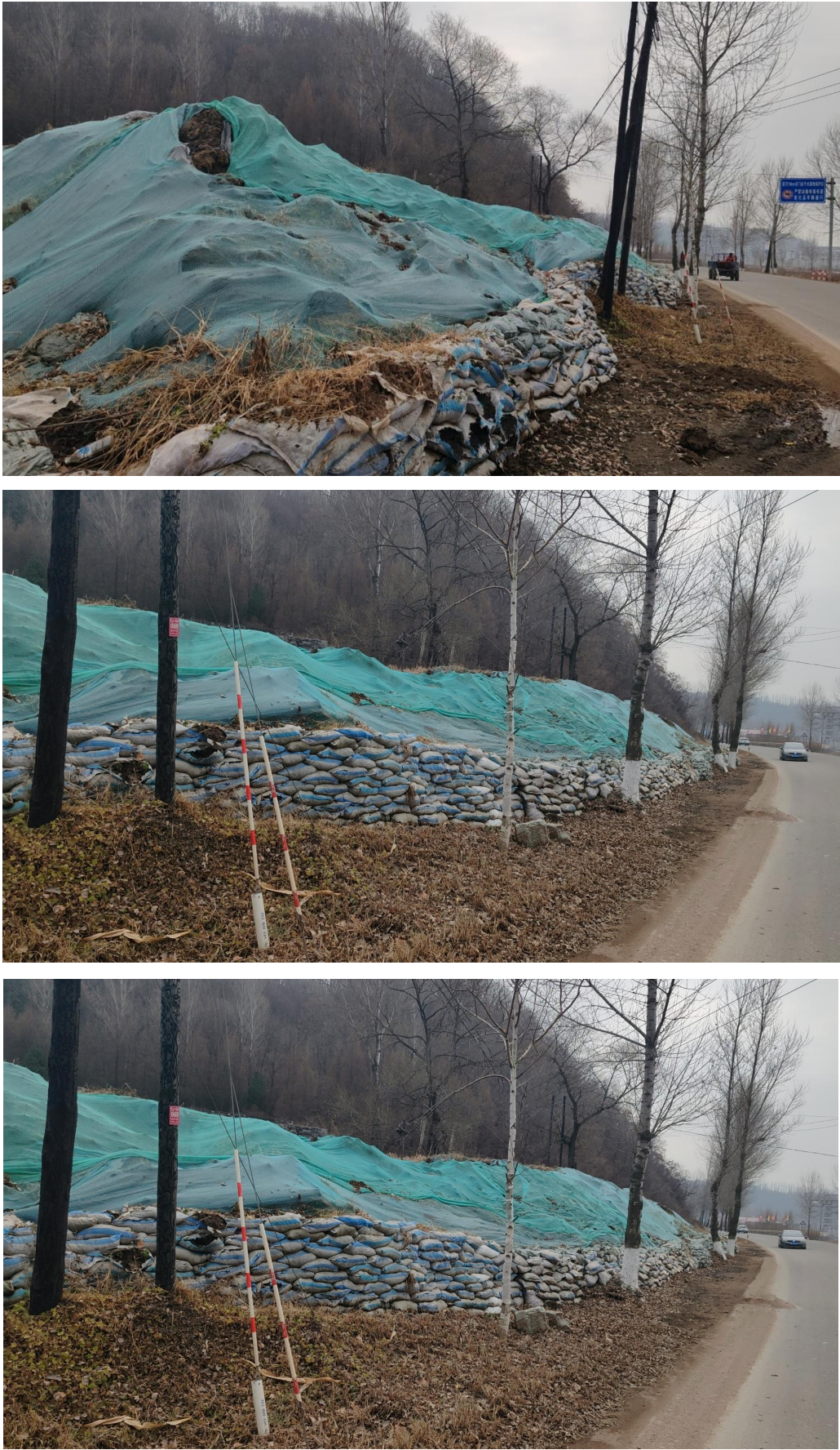
图6-3表土堆放场现场照片
