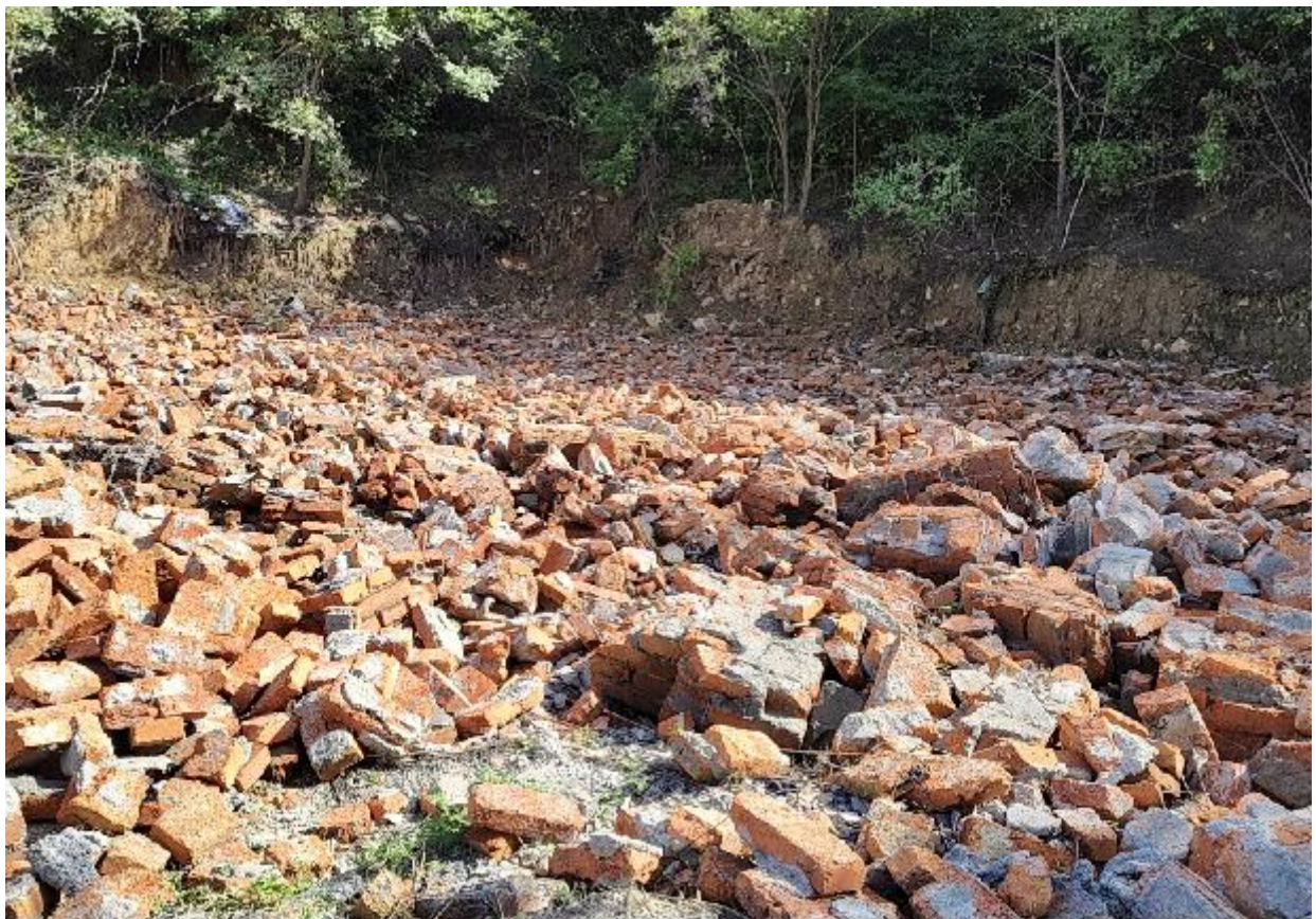
照片 6-5 建筑物拆除照片
